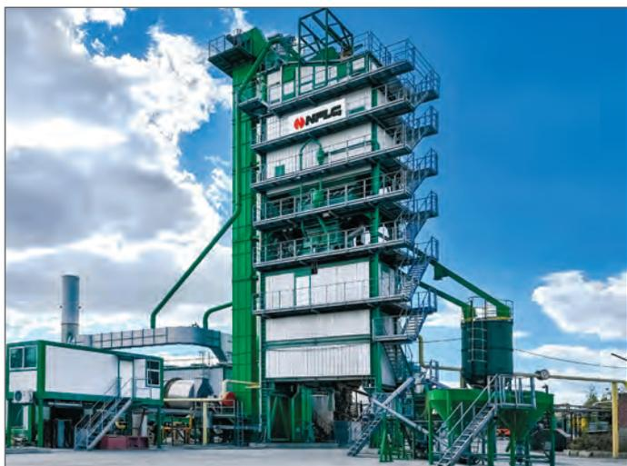
ности выпуска цветных асфальтобетонов — спроектировали линию для подачи пигмента и отдельный трубопровод для транспортировки бесцветного вяжущего; для комфортной работы специалистов АБЗ — произвели большую кабину оператора — шириной 4,6 и длиной 9 м, в два этажа, с комнатами отдыха и приема пищи. Это действительно уникальный проект для команды SOLOMATIC, который, возможно, для кого-то станет примером того, как можно выстроить технологические процессы с учетом долгосрочной перспективы.
