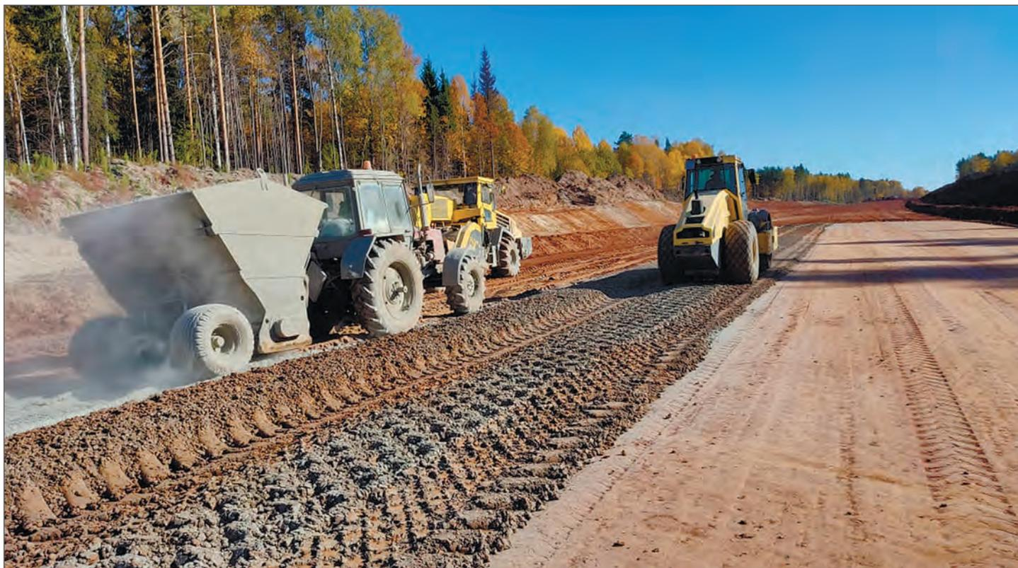
Состав и свойства КМВ должны подбираться индивидуально под характеристики конкретного грунта: число пластичности, степень переувлажнения, pH, содержание и тип растворимых солей, содержание органических соединений, минералогического состава грунта и пр.
