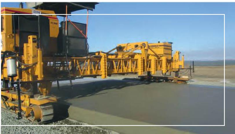
Текстурировщик GOMACO TC-600 – с его помощью выполняются работы по текстурированию бетонной поверхности и распределению пленкообразующих материалов для ухода за бетоном.
