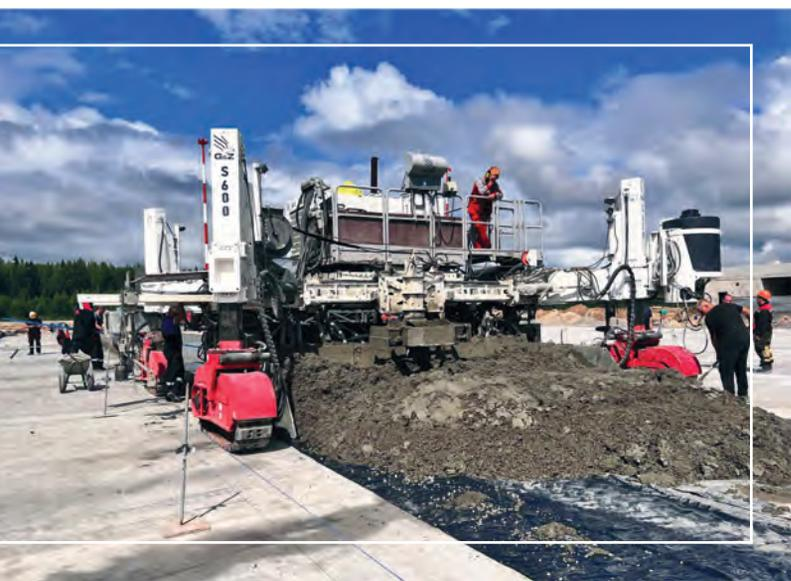
Современный магистральный бетоноукладчик G&Z S600 со скользящей опалубкой имеет меньшие размеры по сравнению с тяжелыми бетоноукладчиками.
